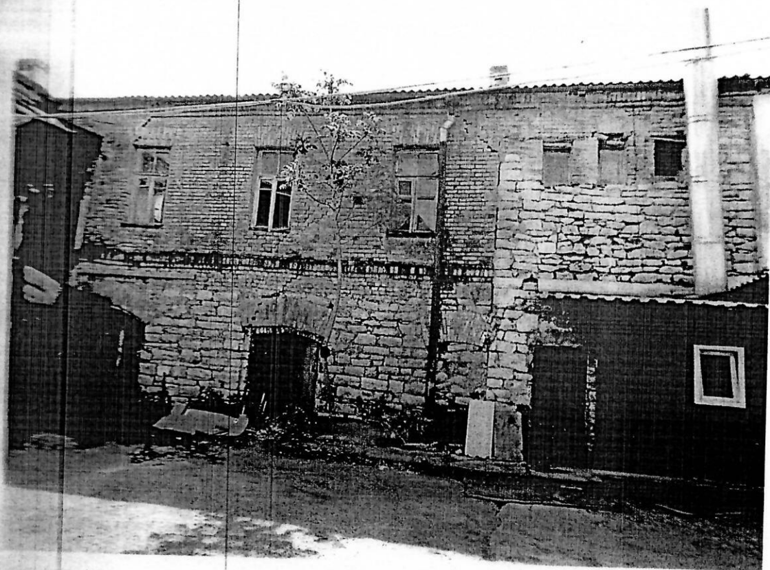
Фото 14-15. Объект культурного наследия регионального значения «Особняк», конец XIX в., расположен по адресу (местонахождение): Ставропольский край, г. Пятигорск, улица Дарьявского, 41. Фрагменты дворового фасада.
